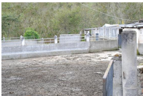
FOTO 43 Instalaciones de hato lechero Playa Alta/09/2015
