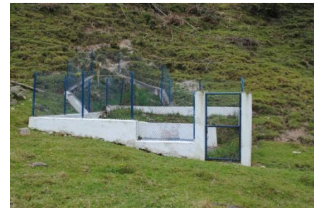
FOTO 55 TANQUE DE AGUA Cartagena/09/2015
